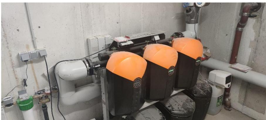
Abbildung 13 Enthärtungsanlage
