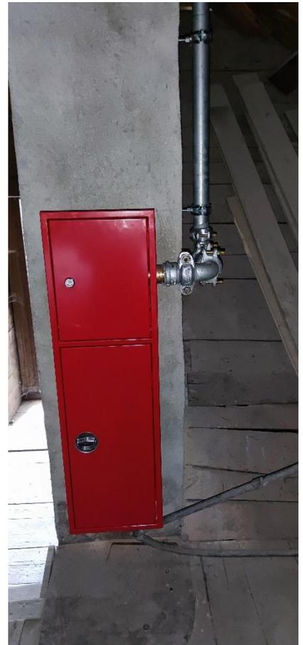
Abbildung 9 Trockene Löschleitung
